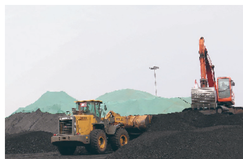
挖机在港口作业。
