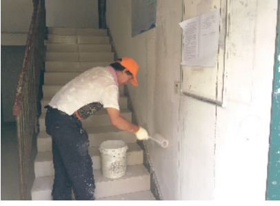
工作人员粉刷小区楼道。
