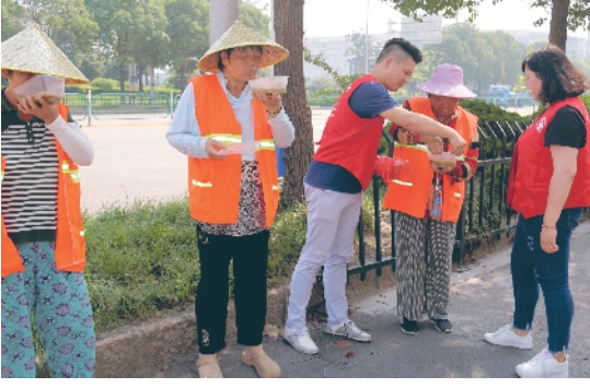
工作人员粉刷小区楼道。
